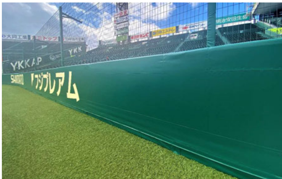
<更新が完了したラバーフェンス>
